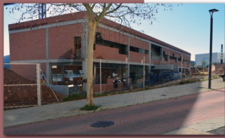
Obras del edificio I+D+i Fotografía: Audiovisuales UVa
