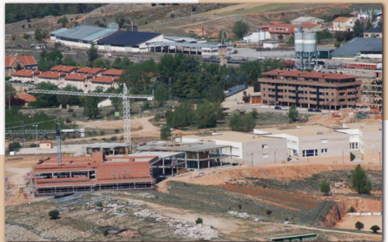
Obras de ampliación del campus universitario de Soria Fotografía: Manuel Cuevas-Mors Finat
